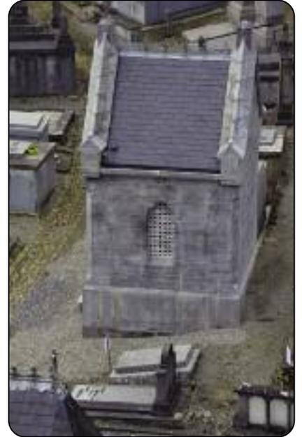
En parallèle, un ossuaire a été créé dans le bas du cimetière et une chapelle à l'état d'abandon a été restaurée: les ouvriers communaux ont procédé à une réfection complète de la toiture et de l'évacuation des eaux de pluie, du zinc du faitage, à un remplacement des pierres cassées et au nettoyage des pierres existantes, à une réfection du plafonnage intérieur et à la pose d'un système de ventilation du caveau se trouvant sous la chapelle.
