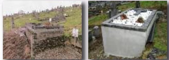
Une concession qui, à l'origine, était construite en pierres cimentées se désagrégant considérablement. Réfection assurée à l'aide d'un cimentage d'enduit dans la masse
